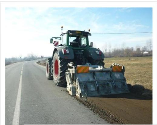
Serremar dispone di frese autocaricanti, in grado di fresare lo strato superficiale del manto stradale per circa 20 - 30cm e di predisporre il piano per la nuova asfaltatura.
