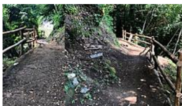
Miagliano, nuova staccionata per il... Altra operazione terminata a pieni voti sul territorio di Miagliano. È stato completamente ripristinato e messo in..."
