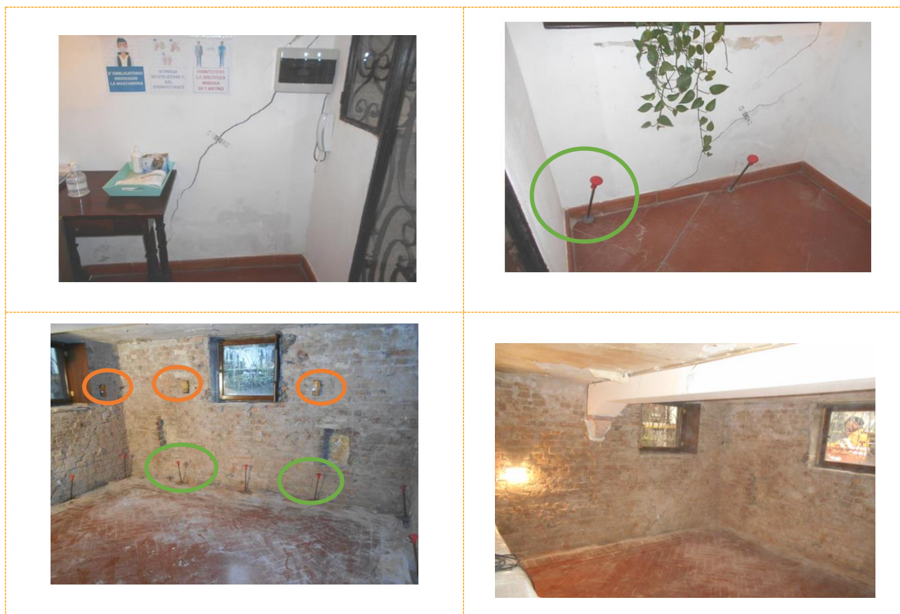
Figura 11 – Esempio di trattamento con URETEK MULTIPONT®: FOTO dell'interno (si notano le cannule di iniezione) e la rilevazione con sistema laser.
