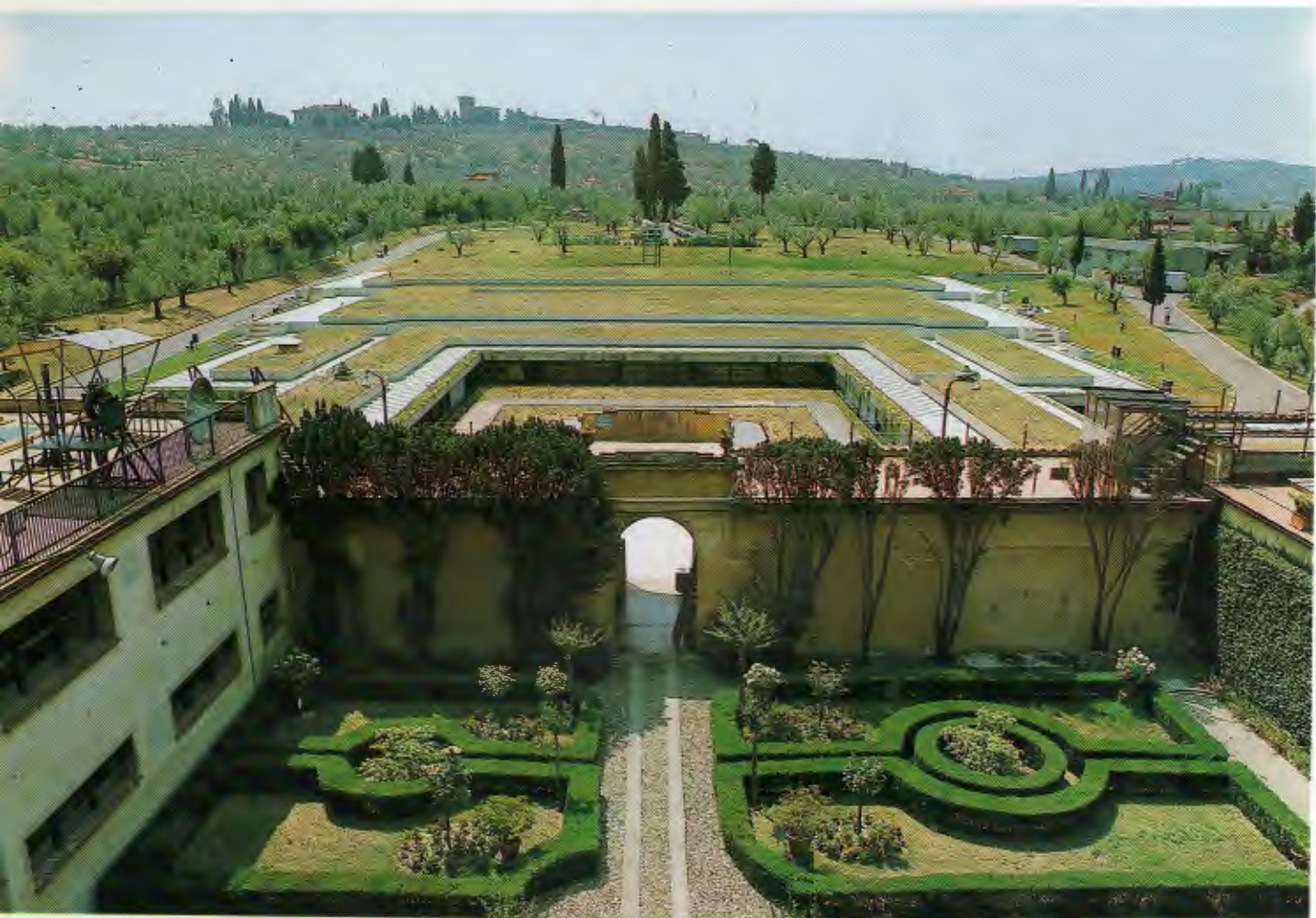
La stretta integrazione tra nuovo e vecchio risulta evidente da queste fotografie: dal giardino interno della villa San Martino il nuovo complesso segue la tendenza della collina con gradoni a giardino sfalsati, seguendo l'asse della stessa villa / The integration of new and old appears clearly from these photographs: from the inner garden of San Martino villa the new complex follows the slope of the hill by staggered stepped gardens along the axis of the villa
