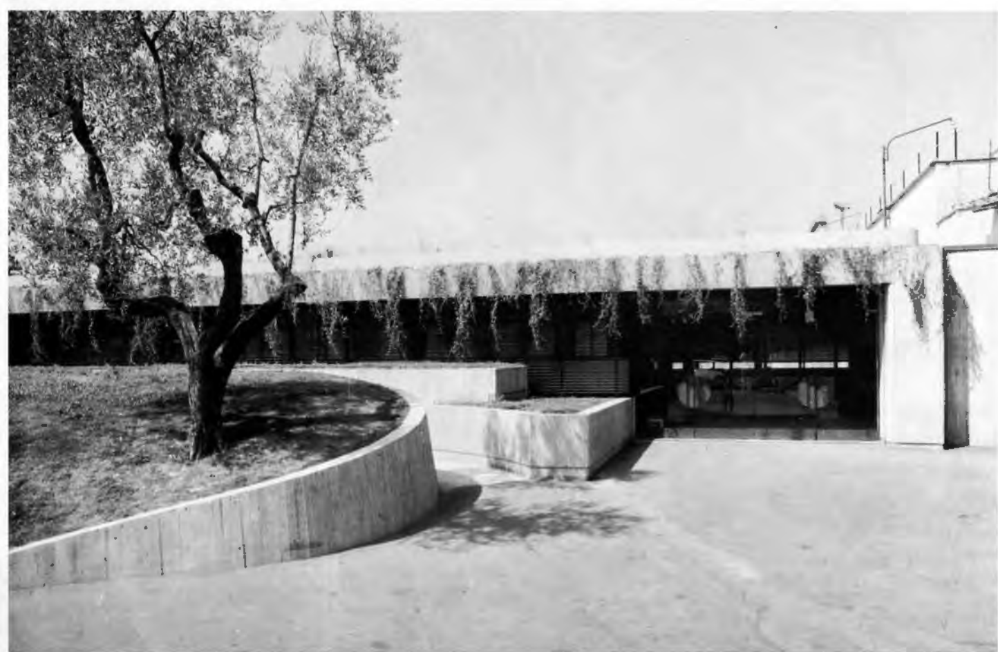
L'ingresso dell'edificio. Si può notare come in corrispondenza del passaggio, la quota si abbassi al di sotto del terreno naturale. A sinistra dietro l'olivo, una delle uscite di sicurezza dalla zona officina interrata / The entrance of the building. At the passage the level lowers below the natural level of the soil. An emergency exit from the underground workshop could be seen on the left, behind the olive tree
