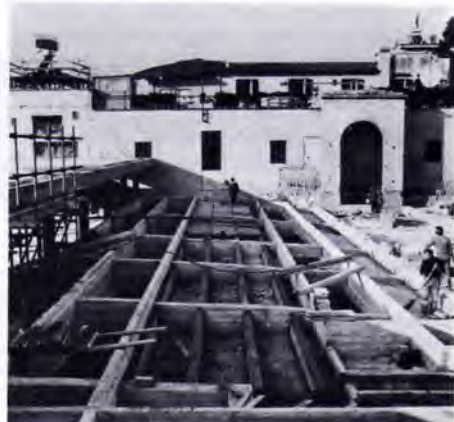
Le strutture che coprono l'officina interrata sotto il cortile / Structures covering the workshop
