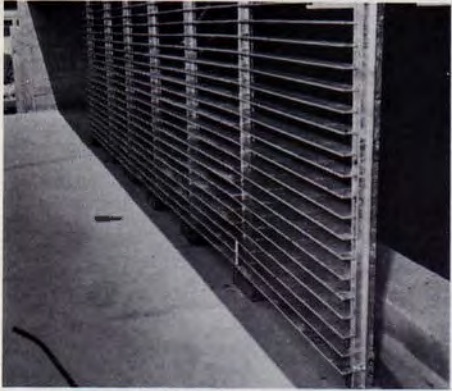
Il primo campione della griglia presentato in opera per le verifiche / The first sample of the grid erected for checking operations
