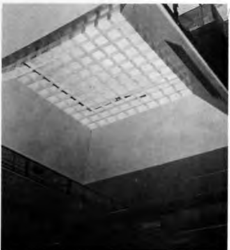
Il nodo che costituisce l'incrocio di ogni maglia. Il pilastro è racchiuso in un carter smontabile fissato con flange al pavimento e raccordato nella parte superiore con le quattro fasce di lamiera che ivi si incrociano e che riquadrano la soffittatura / The knot constituting the crossing of the links. The column is enclosed in a demountable carter fixed to the floor with flanges, and connected on the upper side with the four sheet bands which intersect and frame the ceiling
