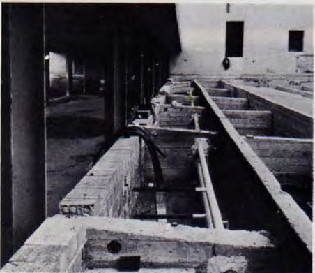
Foto del rustico in cui appare chiaramente la struttura sulla quale si colloca il complesso della finestratura degli uffici sul cortile principale, rappresentata a fianco nello schema assonometrico / Clear view of the structure on which will be placed the frame of the office windows facing the main courtyard (see the axonometry)
