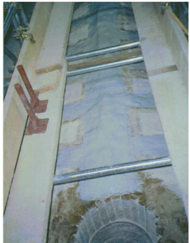
(Alcune fasi di applicazione del tessuto in carbonio usato per ricucire le fessure)
