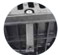
Montaggio della zanca
