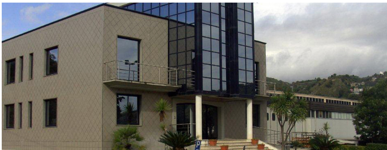
La sede centrale di Catanzaro Catanzaro Headquarters
