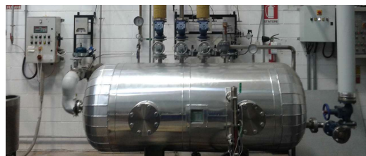
Volano termico di compensazione vapore
