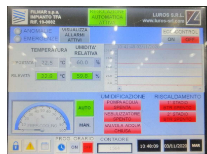
Sistema di Regolazione impianto CDZ
