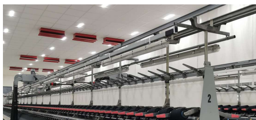
Impianto di distribuzione aria con diffusori a piastra d'urto
