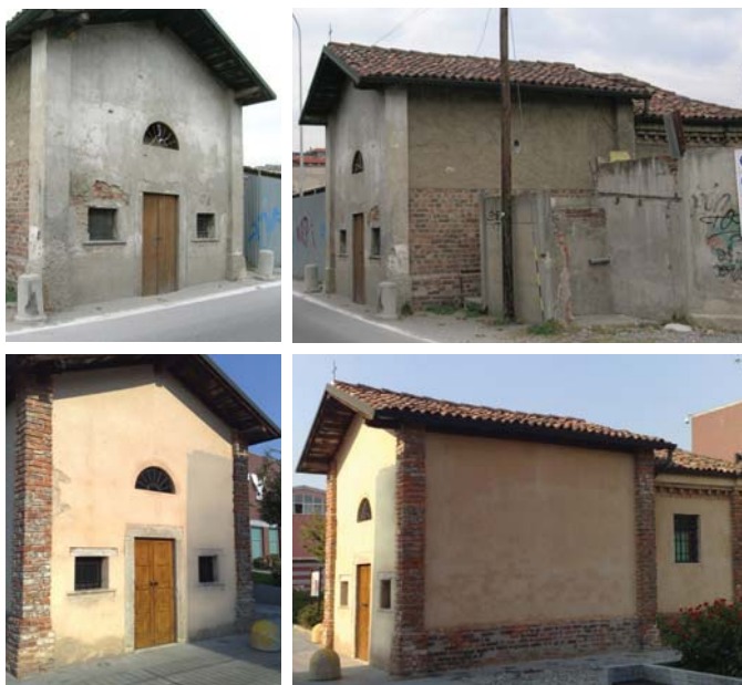
La chiesetta prima e dopo i restauri.
