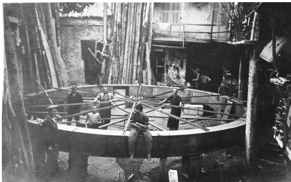
Ruota per mulino, diametro 8,27m. – 1936- per Piaggia
