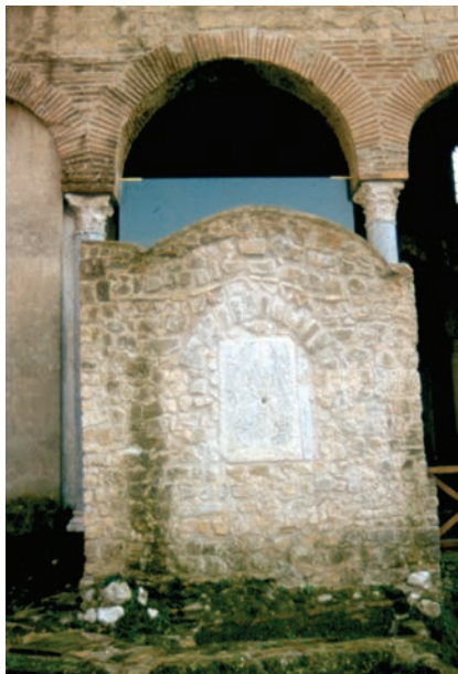
Fig. 69 Resti dell'abside dell'aula ad corpus
