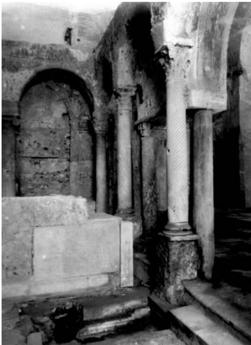
Fig. 79 - Angolo nord-ovest dell'altare, dopo la demolizione della parte occidentale della sopraelevazione e lo smontaggio delle tombe dei vescovi (1954).
