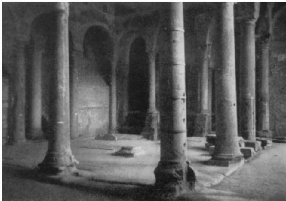
Fig. 88 - Edicola mosaicata dopo la completa demolizione dell'altare di S. Felice; a destra s'intravedono i pilastrini depositati sul pavimento (fine anni Cinquanta).
