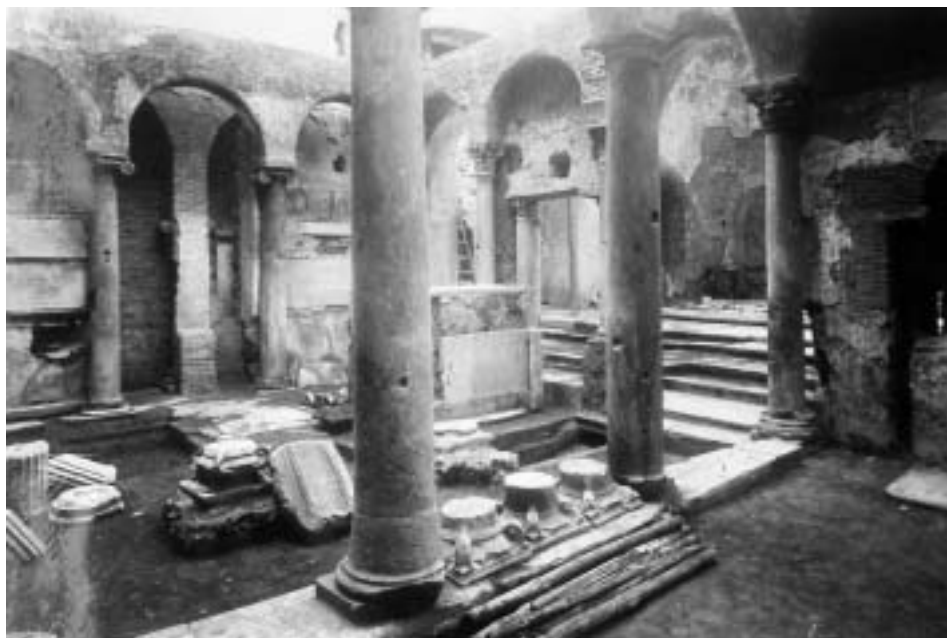
Fig. 26 - Edicola mosaicata vista da nord-est; tra le tombe dei vescovi Felice e Paolino iunior si riconosce uno dei pilastri del triforium demolito da Chierici nel 1954 e sostituito con una colonna in muratura.
