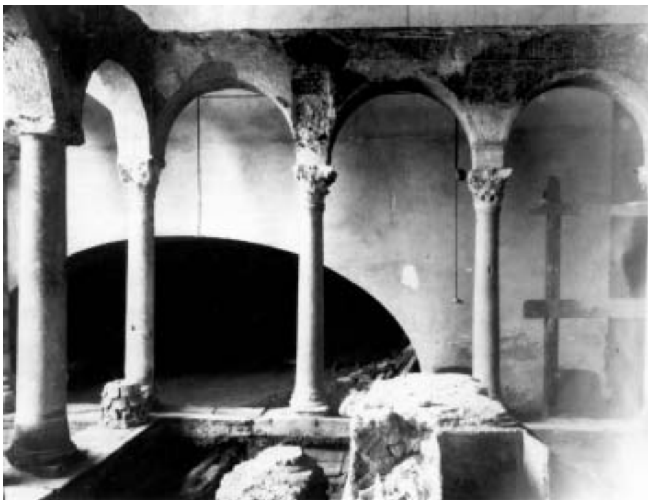
Fig. 58 - Edicola mosaicata vista da ovest (1954); in primo piano l'altare di S. Felice con la fenestella dopo la demolizione della parte meridionale della sopraelevazione.
