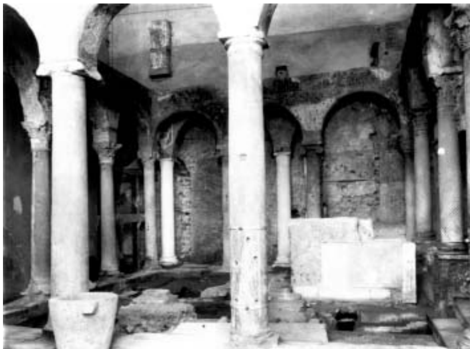
Fig. 78 - Altare visto da nord nel 1954, dopo la demolizione della parte occidentale della sopraelevazione e lo smontaggio delle tombe dei vescovi.
