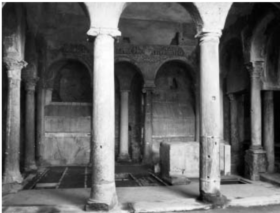
Fig. 83 - Edicola mosaicata con i resti dell'altare di S. Felice durante la messa in opera del calpestio in cemento (1955).
