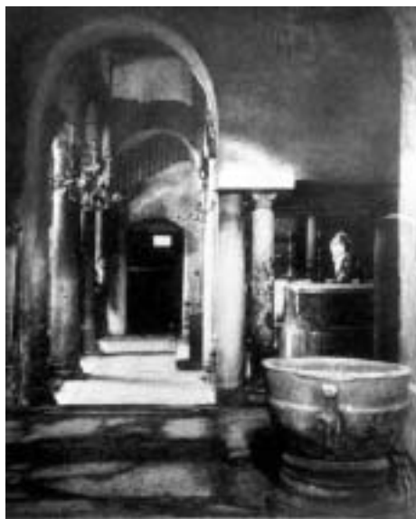
Fig. 55 - L'altare di S. Felice visto dal presbiterio occidentale della basilica, prima dei lavori degli anni Trenta.
