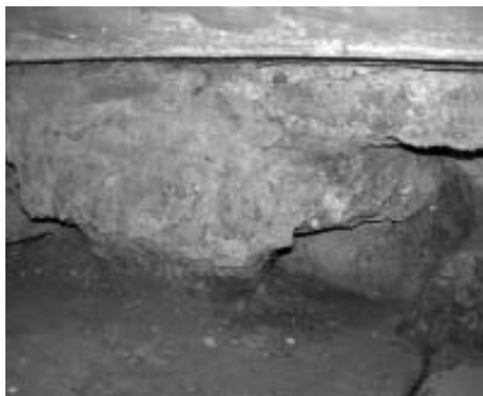
Fig. 30 - Struttura muraria 930 impiantata sul terreno 929 e sulle tombe 926 e 927.
