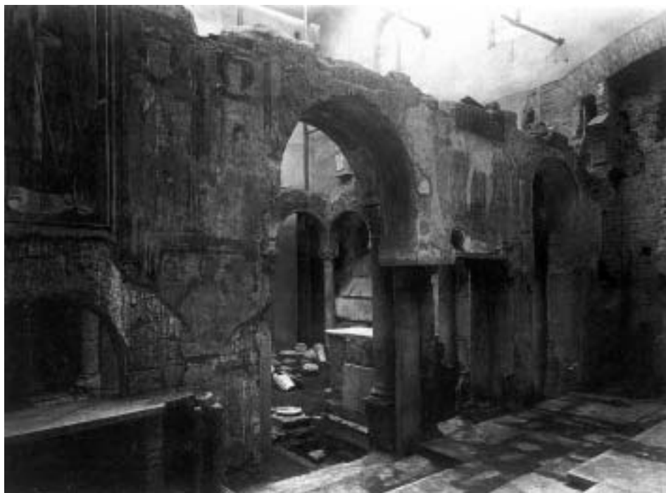
Fig. 80 - Altare visto dal presbiterio nel 1954, prima dello smontaggio della tomba del vescovo Felice; la parte ovest della sopraelevazione dell'altare non è stata ancora demolita.
