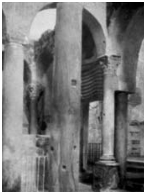
Fig. 72 - Edicola mosaicata con altare e tamponatura dell'arco centrale del lato ovest; sul lato nord dell'altare s'intravede la recinzione metallica (1933).
