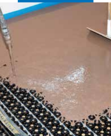
Pompaggio e livellamento di Novoplan Maxi
