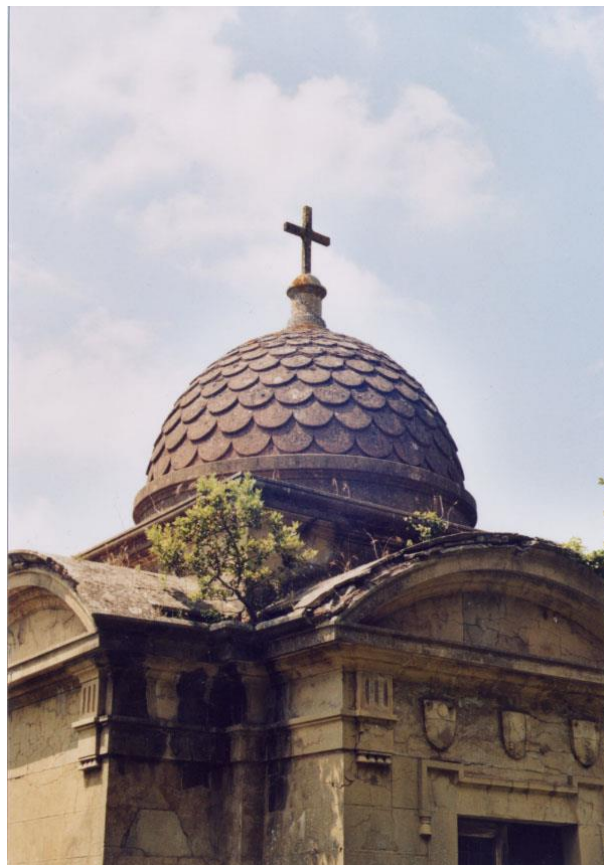
Foto esterne della Cappella in cui è ben visibile la mancanza di manutenzione che probabilmente risale fin dall'epoca della costruzione. La copertura è infestata da varia vegetazione.
