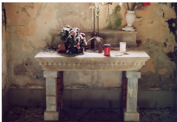
Foto interne della Cappella: anche all'interno è ben visibile lo stato di abbandono in cui versa, le infiltrazioni d'acqua dalla copertura hanno determinato il distacco di tutte le lapidi dei loculi.
