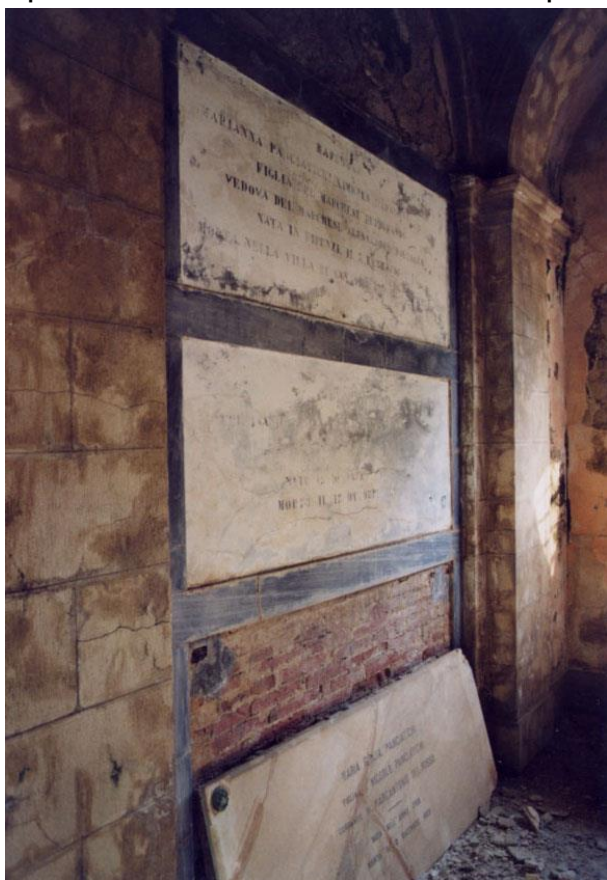
Foto interne della Cappella: anche all'interno è ben visibile lo stato di abbandono in cui versa, le infiltrazioni d'acqua dalla copertura hanno determinato il distacco di tutte le lapidi dei loculi.
