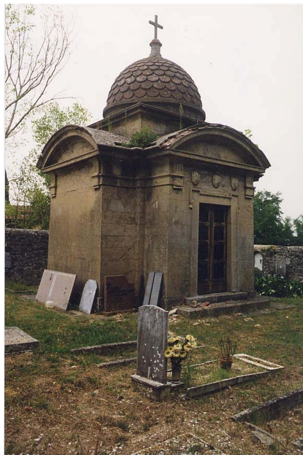
Foto esterne della Cappella in cui è ben visibile la mancanza di manutenzione che probabilmente risale fin dall'epoca della costruzione. La copertura è infestata da varia vegetazione.
