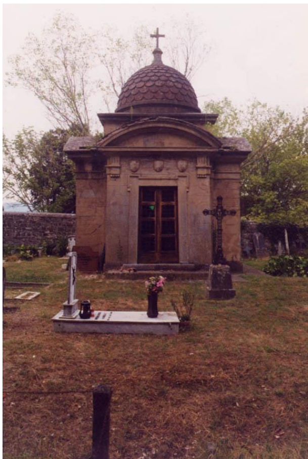
Foto esterne della Cappella in cui è ben visibile la mancanza di manutenzione che probabilmente risale fin dall'epoca della costruzione. La copertura è infestata da varia vegetazione.
