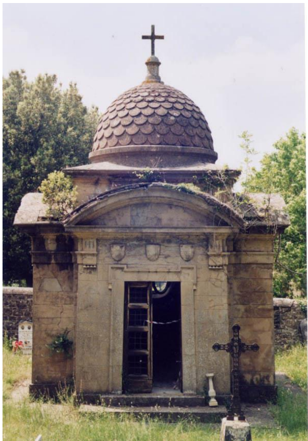
Foto esterne della Cappella in cui è ben visibile la mancanza di manutenzione che probabilmente risale fin dall'epoca della costruzione. La copertura è infestata da varia vegetazione.
