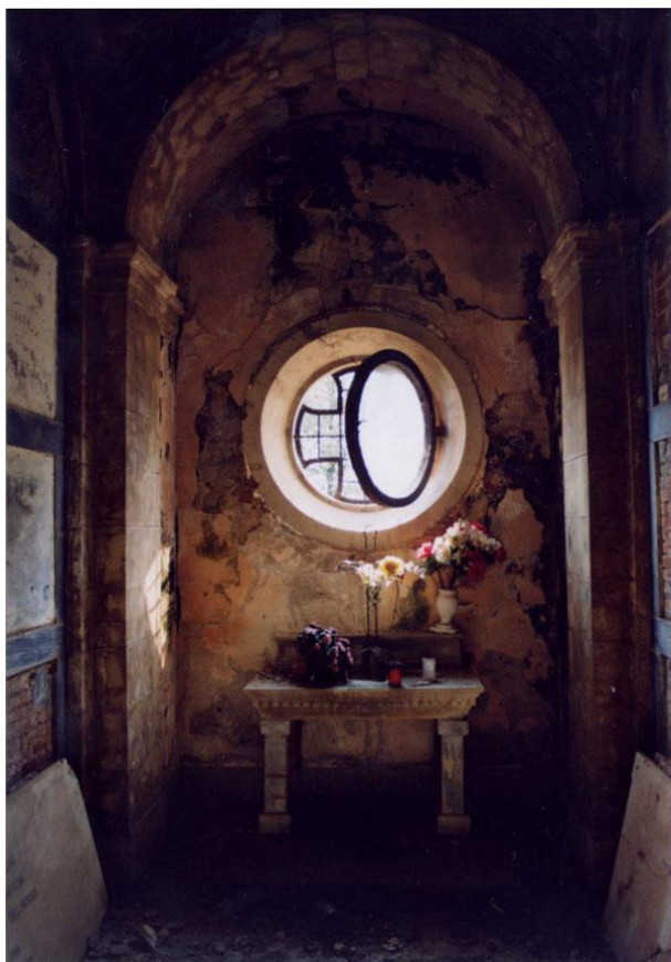
Foto interne della Cappella: anche all'interno è ben visibile lo stato di abbandono in cui versa, le infiltrazioni d'acqua dalla copertura hanno determinato il distacco di tutte le lapidi dei loculi.
