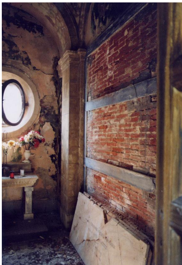
Foto interne della Cappella: anche all'interno è ben visibile lo stato di abbandono in cui versa, le infiltrazioni d'acqua dalla copertura hanno determinato il distacco di tutte le lapidi dei loculi.
