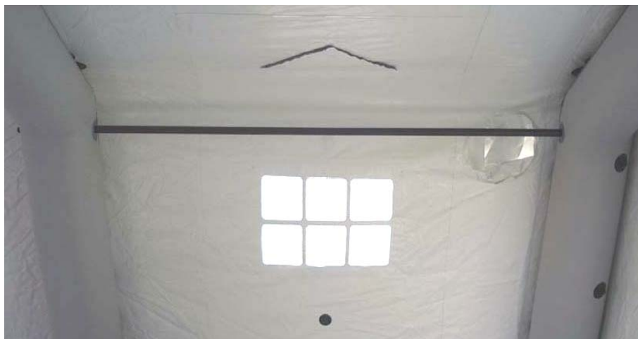
Figure 2.7 – Distanziale installato.
