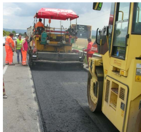
Figura 7 – Stesa e compattazione della pavimentazione
