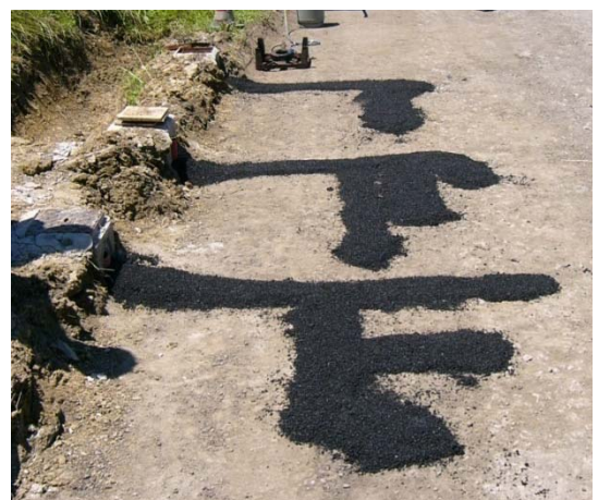
Figura 4 – Protezione dei sensori per il rilievo delle deformazioni
