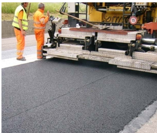
Figura 7 – Stesa e compattazione della pavimentazione
