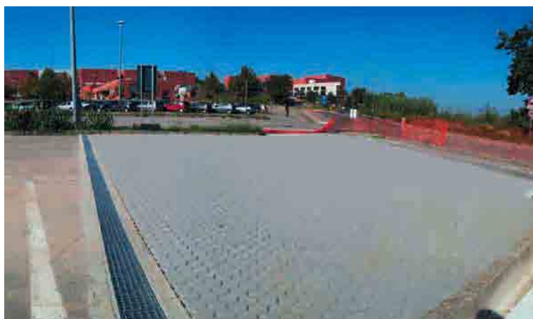
Figura 6 - Parcheggio con pavimentazione permeabile.
