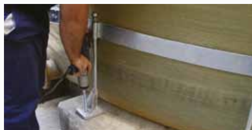
Fascia di ancoraggio con staffe forate, per fissaggio con tassello chimico Anchor band with fixing plates, for installation with chemical bolts Verankerungsring mit Verankerungsplatten, für die Befestigung mit chemischen Dübeln
