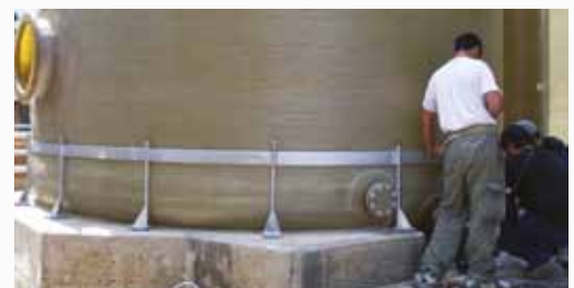
Fascia di ancoraggio con tirafondi – Anchor band with anchor bolts – Verankerungsring mit Ankerschrauben
