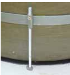
Disco in PE posizionato tra serbatoio e basamento Pe folie to be positioned between tank and concrete PE Folie, die zwischen Behälter und Fundament positioniert werden
