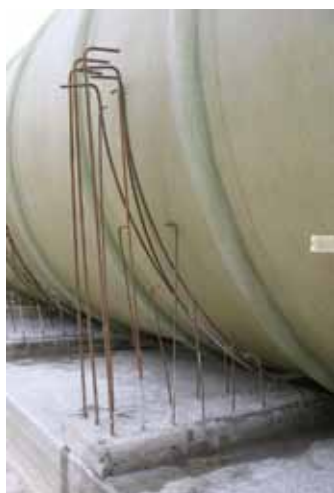
Esecuzione selle in cemento a cura cliente, secondo istruzioni Selip.
