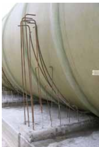
Esecuzione selle in cemento a cura cliente, secondo istruzioni Selip. Realization of concrete saddles by customer according to Selip instructions Erstellung der Betonsätteln wird nach Kundenbetreuung gemäß Selip Anleitung durchgeführt
