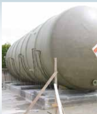
Esecuzione selle in cemento a cura cliente, secondo istruzioni Selip. Realization of concrete saddles by customer according to Selip instructions Erstellung der Betonsätteln wird nach Kundenbetreuung gemäß Selip Anleitung durchgeführt
