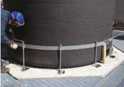
Fascia di ancoraggio con tirafondi – Anchor band with anchor bolts – Verankerungsring mit Ankerschrauben
