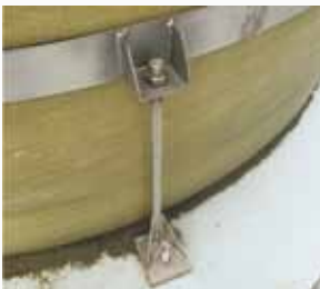
Fascia di ancoraggio con staffe forate, per fissaggio con tassello chimico Anchor band with fixing plates, for installation with chemical bolts Verankerungsring mit Verankerungsplatten, für die Befestigung mit chemischen Dübeln
