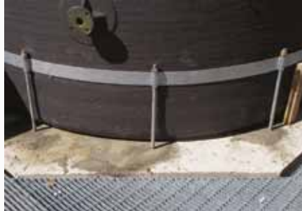
Fascia di ancoraggio con tirafondi – Anchor band with anchor bolts – Verankerungsring mit Ankerschrauben
