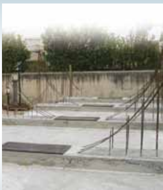
Esecuzione selle in cemento a cura cliente, secondo istruzioni Selip. Realization of concrete saddles by customer according to Selip instructions Erstellung der Betonsätteln wird nach Kundenbetreuung gemäß Selip Anleitung durchgeführt
