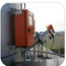
Misura di Portata Ultrasonica a Camino
