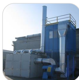
Controllo resa sistema Estrazione Polveri
