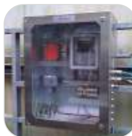
Pannello con Rifrattometro in linea e sua elettronica separata Neste Oil Oy, Rotterdam & Singapore
