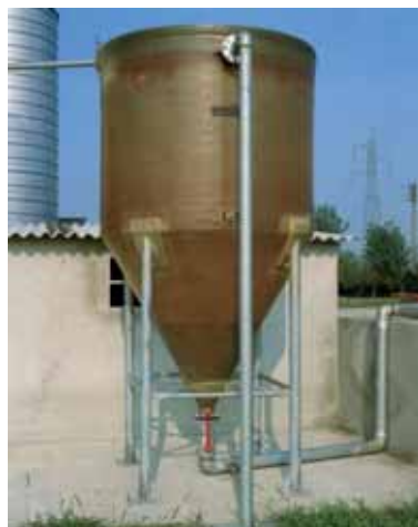
Sedimentatore-Decantatore per reflui di lavorazione, capacità 7 m³. Sedimentator-decanter used for machining reflows, capacity 7 m³. Absetzbecken-Dekanter, für Verarbeitungsrückführung, Kapazität 7 m³.
