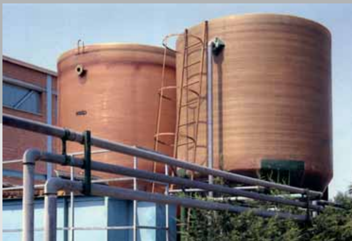
Sedimentatore-Decantatore per liquami, capacità 25 m³. Sedimentator-decanter used for sewage, capacity 25 m³. Absetzbecken-Dekanter, für Schmutzwasser, Kapazität 25 m³.
