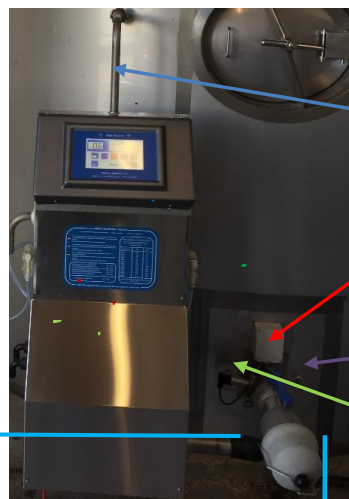
Basamento del serbatoio
