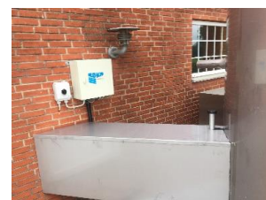
Esempio di coperchio – Sistema con glicole.
