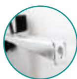
Fissaggio della struttura al muro
